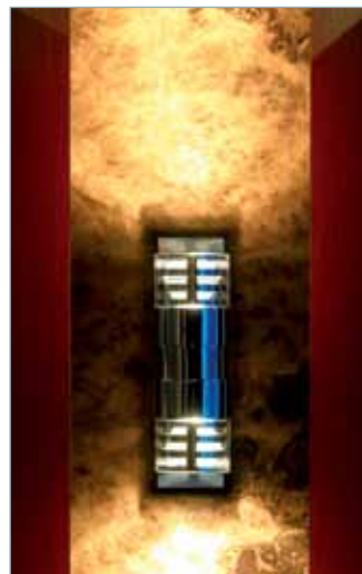
Per Systemcontroller wie der Philips Pronto wird die farbliche Anpassung der seitlichen Lichtsäulen realisiert. Mit R-G-B-Reglern kann man dabei die Farben Rot, Grün und Blau einzeln mischen. Auch ein automatischer Farbverlauf ist vorhanden.
